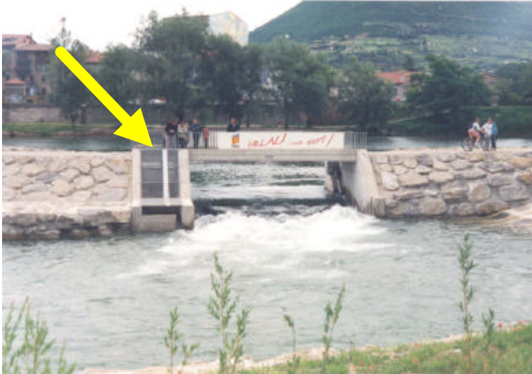
Kuva 5. Millaun toteutuksen yläpään säädettävä patoluukku ja kalan ohitusreitti (pystyrakokalaporras) patoluukun vasemmalla puolella. (Kuva: Hydrostadium)
